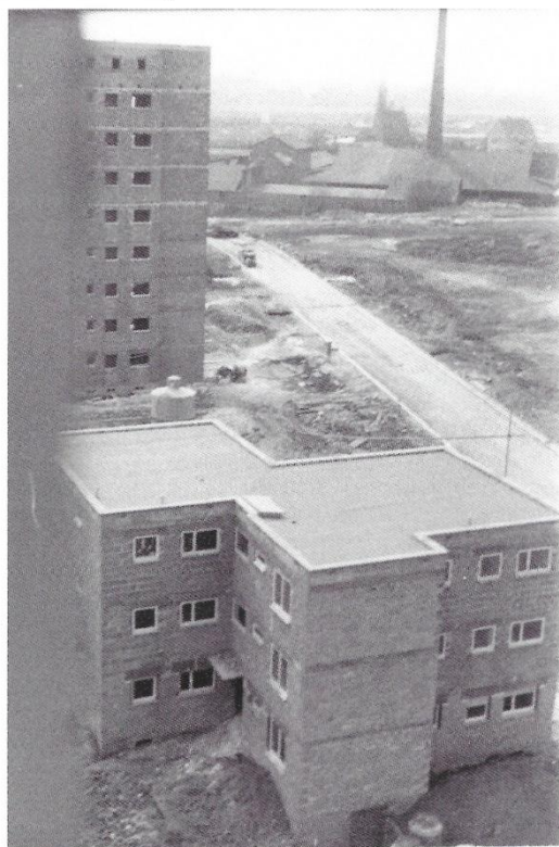
Nordweststadt im Bau
